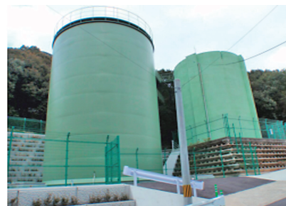
島崎配水池 築造平成22年7月
