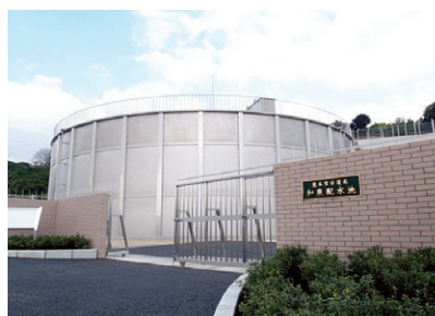
和泉配水池 築造平成18年1月
