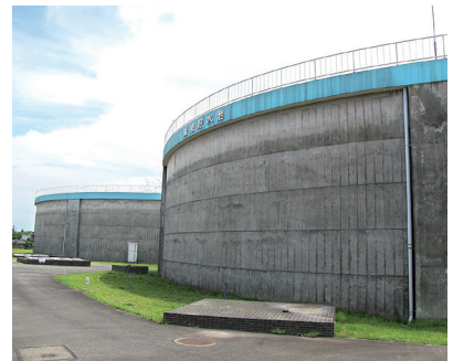
配水池(災害対策用貯水施設) 地震発生時、緊急遮断弁によって配水池の水を確保します
