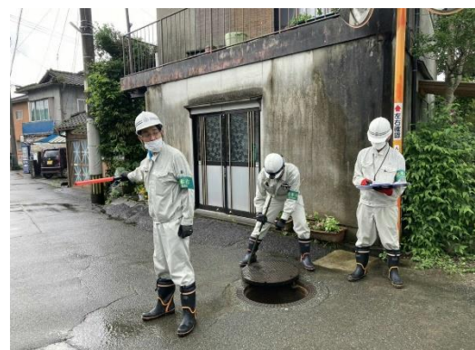
【管渠の調査状況】
