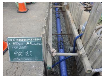
災害復旧で布設した下水道管路
