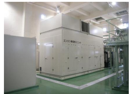
中部浄化センターの消化ガス発電設備
