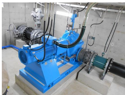
戸島送水場の小水力発電設備
