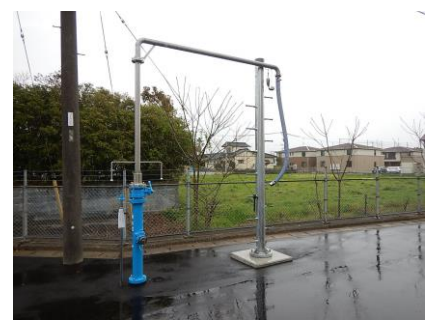
川尻配水場に新設した給水塔
