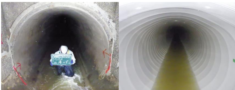
下水道管路の更新（左：更新前、右：更新後）
