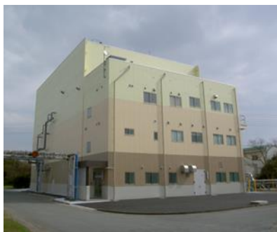
南部浄化センターの固形燃料化施設
