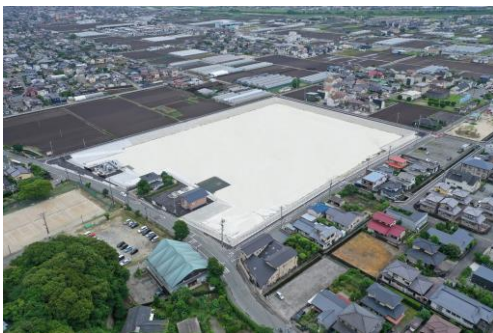
坪井川第3排水区雨水調整池
