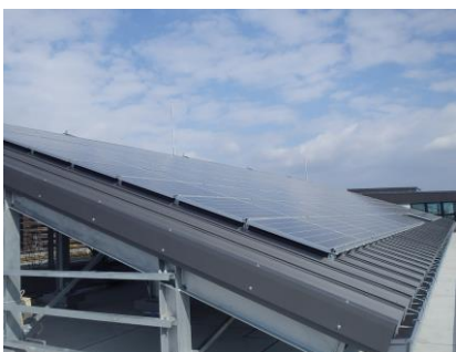
局本館屋上の太陽光発電設備
