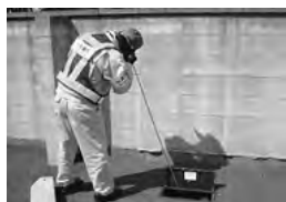
漏水調査の様子
