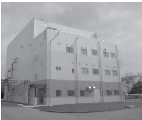
固形燃料化施設
