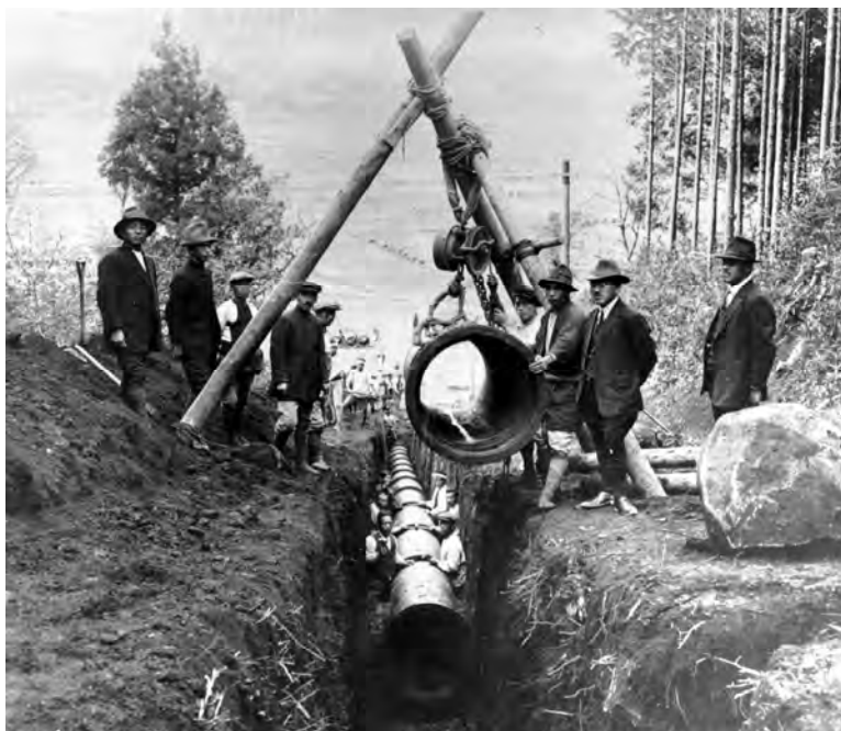
八景水谷送水管布設工事（大正期）
