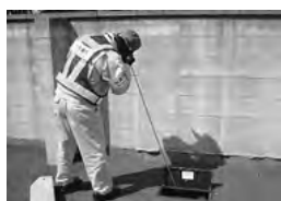
漏水調査の様子
