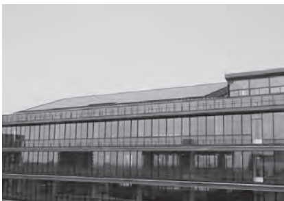
上下水道局本館
