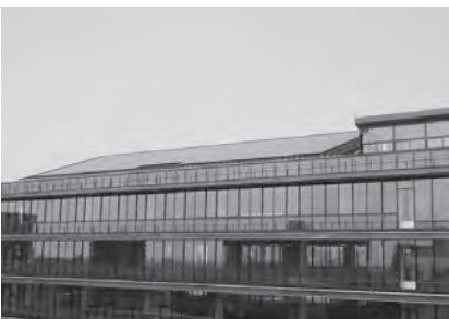
上下水道局本館
