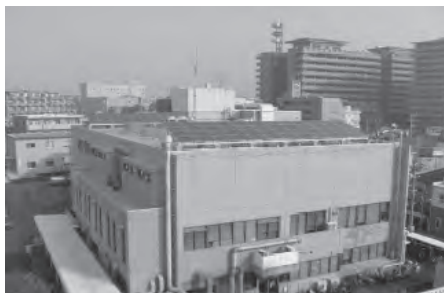
上下水道局別館
