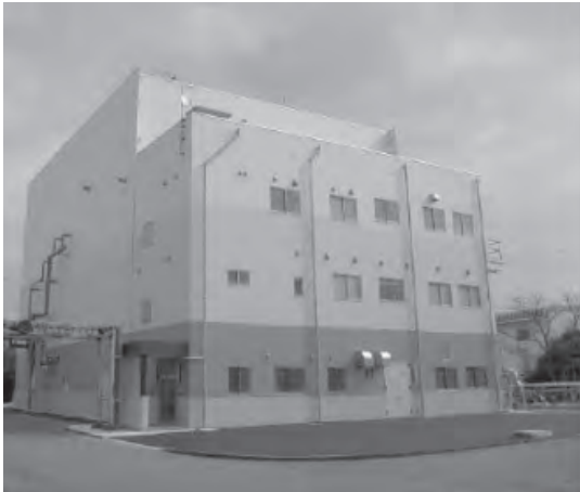
固形燃料化施設
