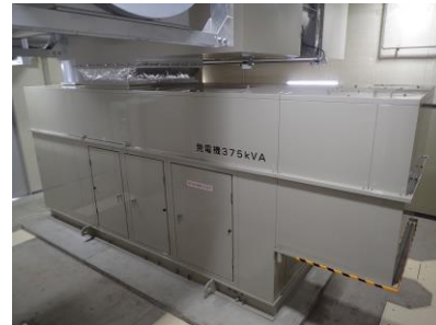
更新した非常用発電設備（川尻水源池）
