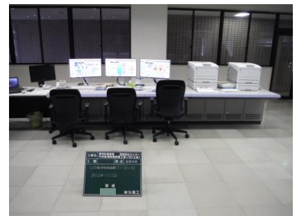
更新した施設機器（西部浄化センター）
