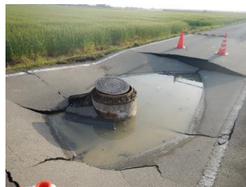
熊本地震による被害 (道路陥没、マンホール浮上)
