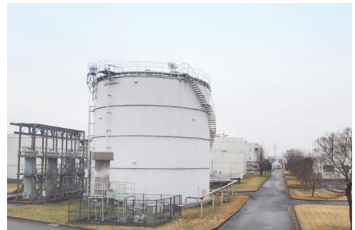
東部浄化センターの消化ガスタンク
