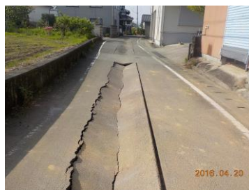
熊本地震による被害 (道路陥没、マンホール浮上)
