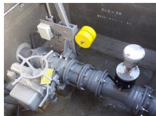
舞原配水場に新設した緊急遮断弁
