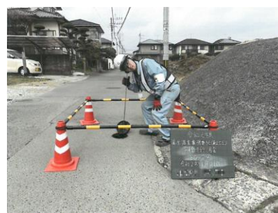
ステンレスに更新した健軍 1 号井 井戸の更生工事（ブラッシング作業） 弁検音聴調査（漏水調査）
