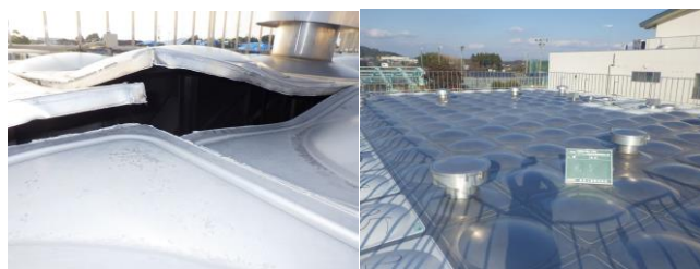
被災した舞原配水池（左：修繕前、右：修繕後）
