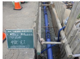
災害復旧で布設した下水道管路
