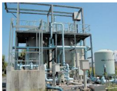
再生水を利用するための砂ろ過施設
