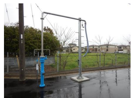
川尻配水場に新設した給水塔
