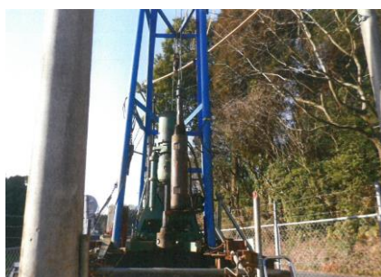
ステンレスに更新した健軍 1 号井 井戸の更生工事（ブラッシング作業） 弁検音聴調査（漏水調査）
