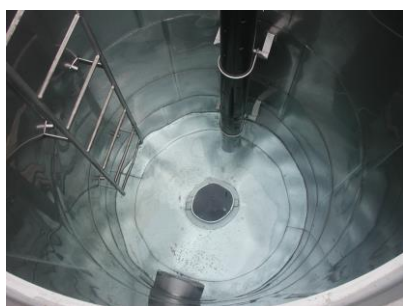
ステンレスに更新した健軍 1 号井 井戸の更生工事（ブラッシング作業） 弁検音聴調査（漏水調査）
