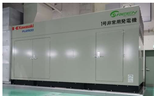
東部浄化センター地震対策
