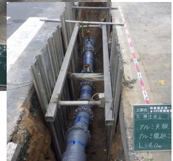
補給管の整備 （口径300mm）
