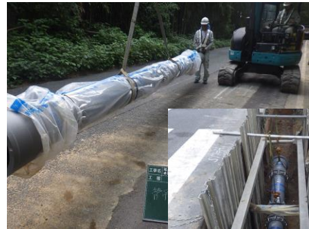
補給管の整備 （口径300mm）
