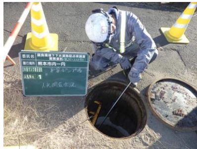
腐食環境下における管路の点検
