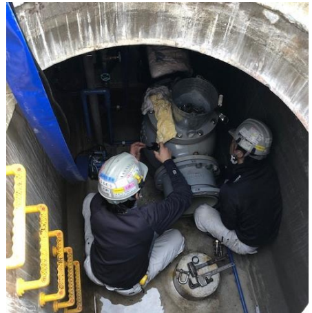
減圧弁の取替工事
