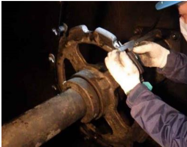
下水道施設の点検調査
