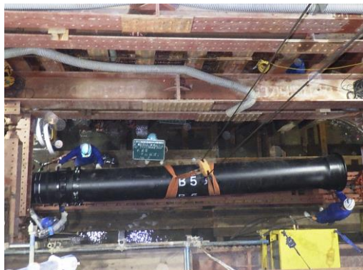
推進工法での布設（口径600mm）
