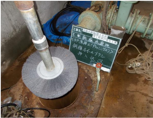
取水井戸の更生（ブラッシング）
