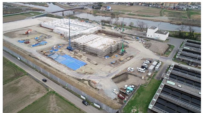
高度処理施設の整備（R5供用開始予定）
