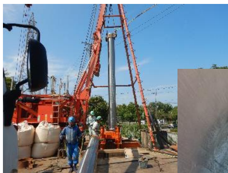
取水井戸の更新
