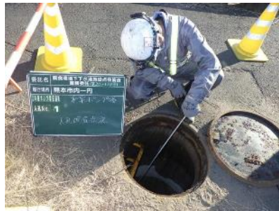
腐食環境下における管路の点検
