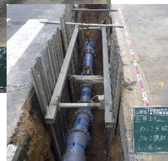
補給管の整備 (口径300mm)
