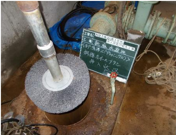
取水井戸の更生（ブラッシング）
