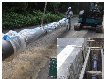
補給管の整備 (口径300mm)
