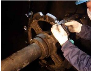
下水道施設の点検調査
