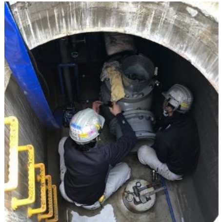
減圧弁の取替工事
