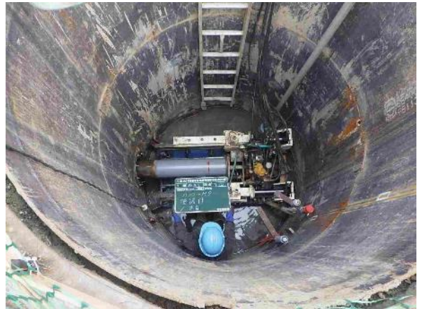
下水道管路の布設
