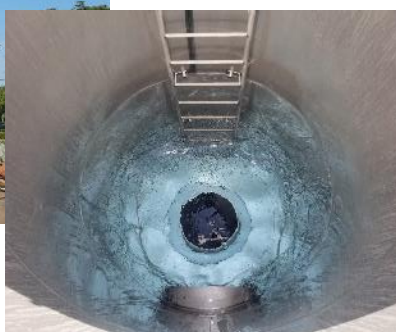
補給管の整備 (口径300mm)
