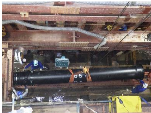
推進工法での布設（口径600mm）
