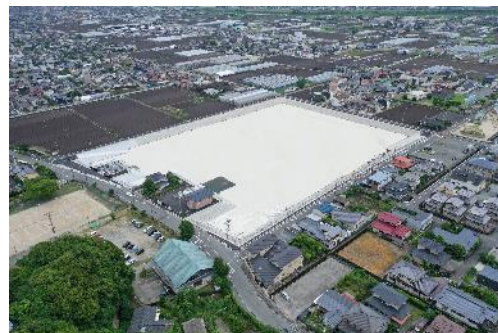
令和元年度に完成した 坪井川第3排水区雨水調整池
