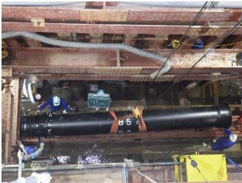
推進工法での布設（口径600mm）
