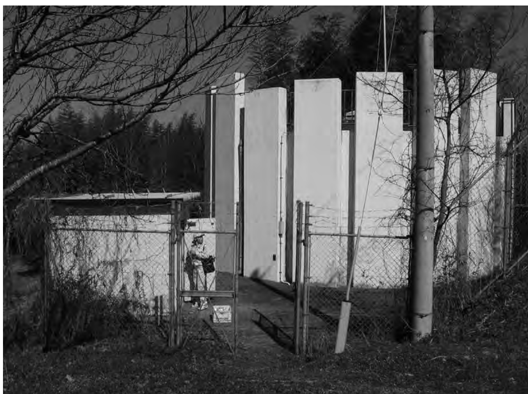
工業用水道配水池
