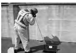
漏水調査の様子
