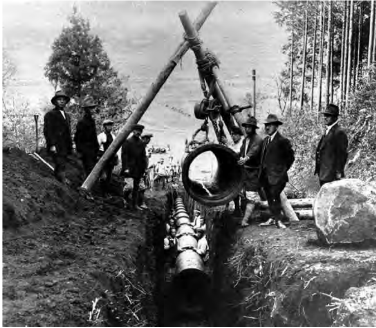
立田山送水管布設工事（大正期）
