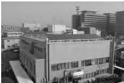
上下水道局別館
