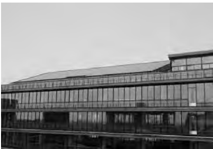
上下水道局本館
