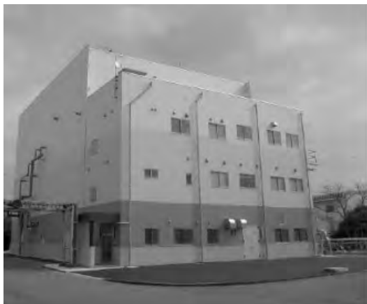
固形燃料化施設
