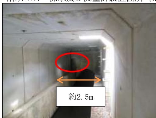
雨水吐口 採水及び流量計設置箇所 (※足場が必要)
