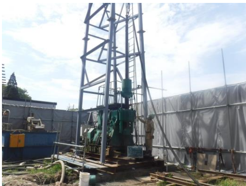
一木取水4号井のさく井工事
