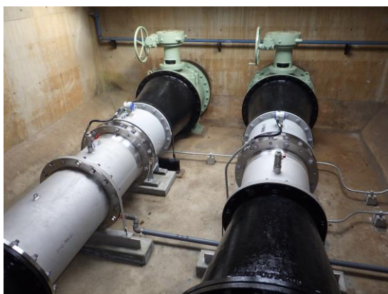
更新した流量計(中部浄化センター)
