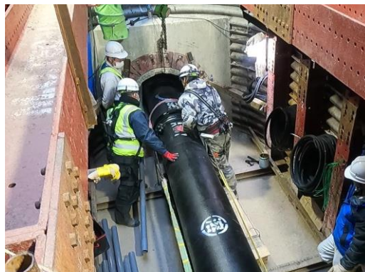
推進工法による基幹管路の布設
