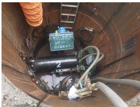
下水道管路の布設(推進工事)
