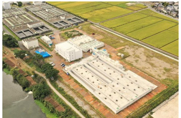
高度処理施設の整備(R5供用開始予定)
