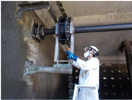
下水道施設の点検調査
