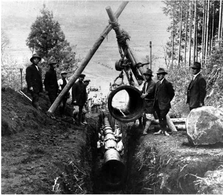
立田山送水管布設工事（大正期）
