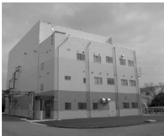
固形燃料化施設
