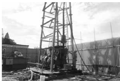
一木取水4号井のさく井工事
