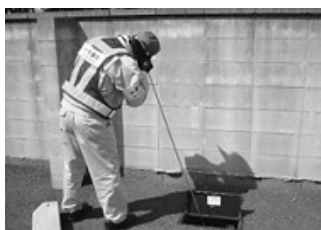
漏水調査の様子
