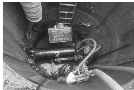
下水道管路の布設工事
