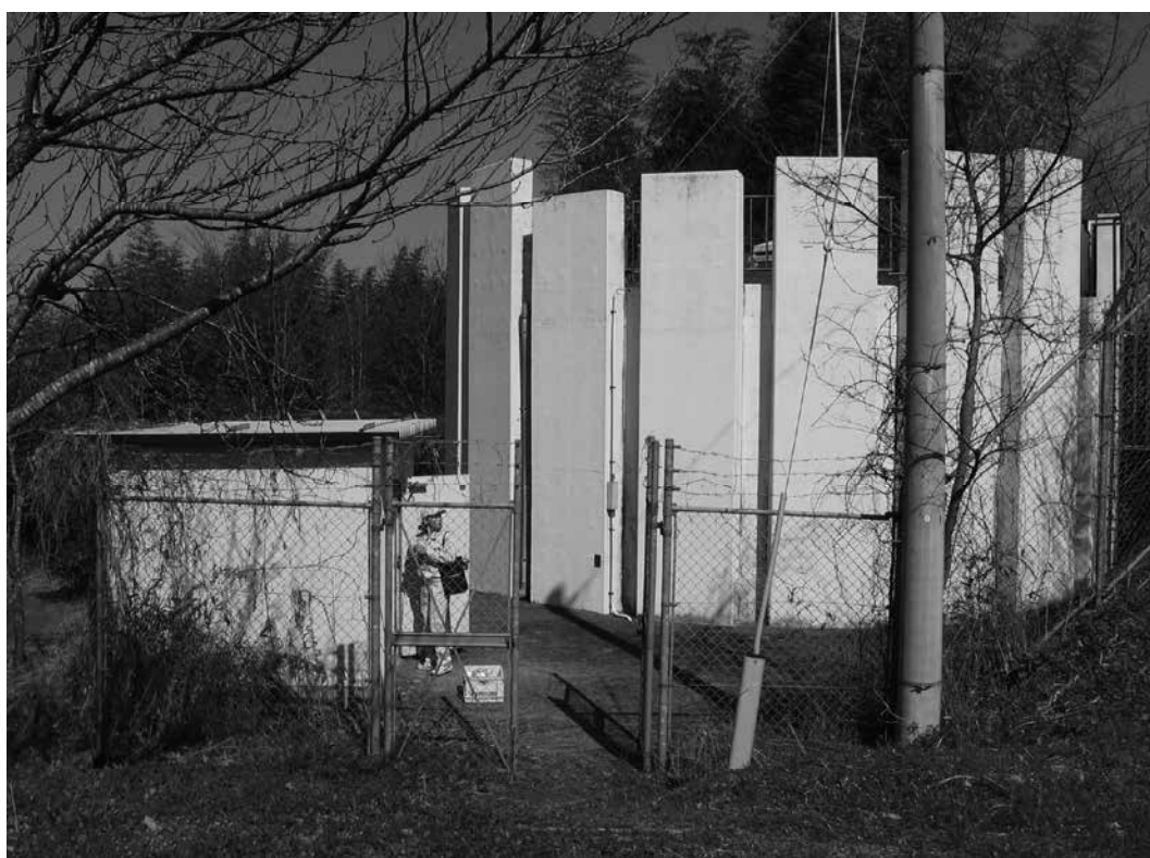
工業用水道配水池
