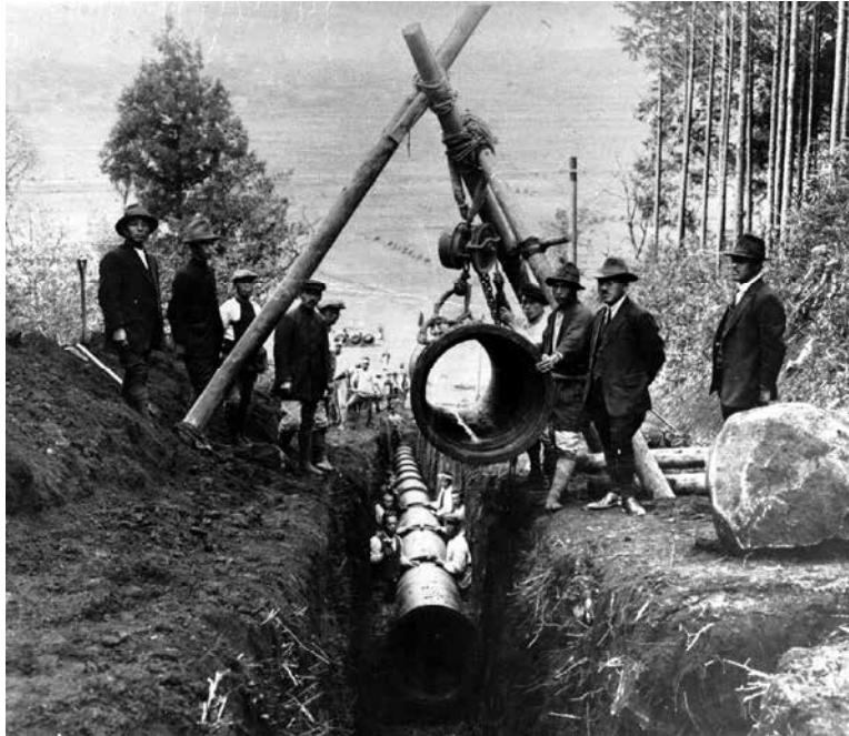
立田山送水管布設工事（大正期）
