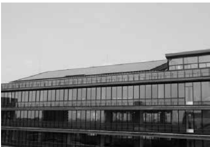
上下水道局本館
