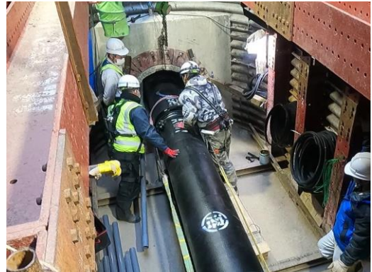
推進工法による基幹管路の布設
