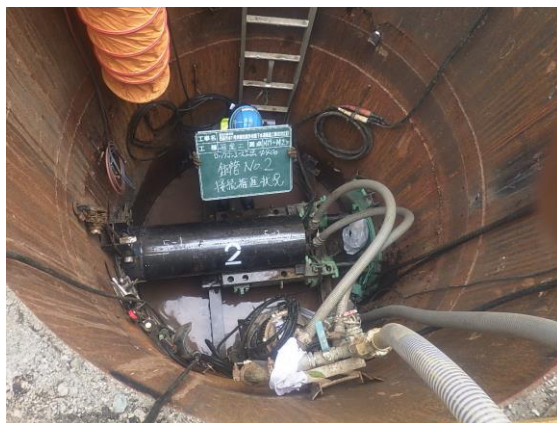
下水道管路の布設(推進工事)
