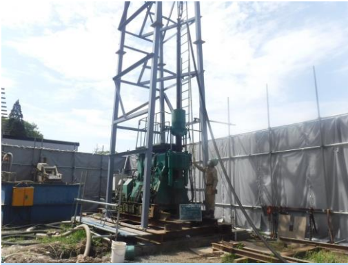
一木取水4号井のさく井工事
