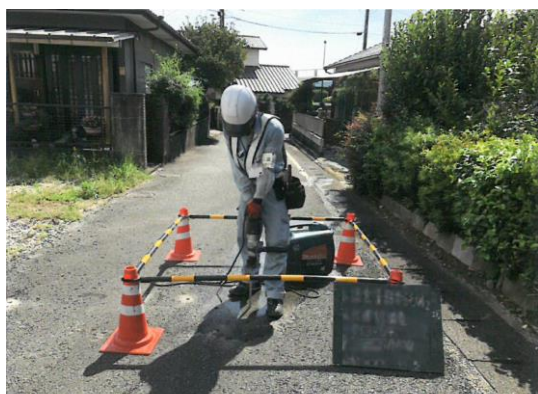
漏水確認調査
