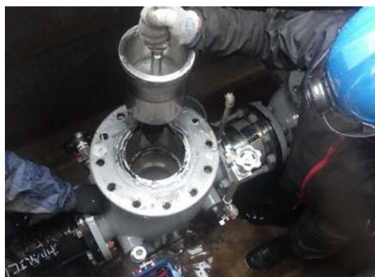
減圧弁の分解整備
