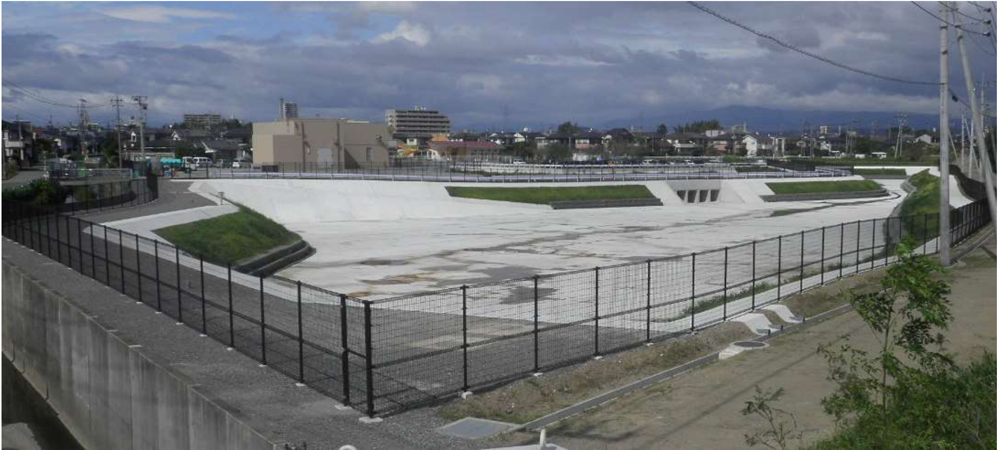
雨水調整池 敷地面積23,000㎡ 貯留容量43,000m 3
