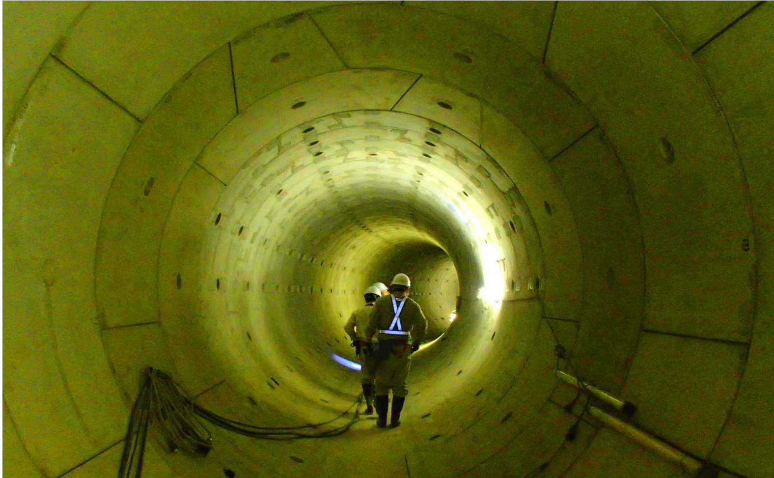
バイパス貯留管 \phi 3.25\text{m} L=1.47\text{km} 貯留容量 12,000\text{m}^3
