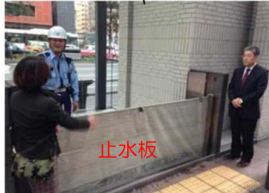
▲止水板の設置補助
