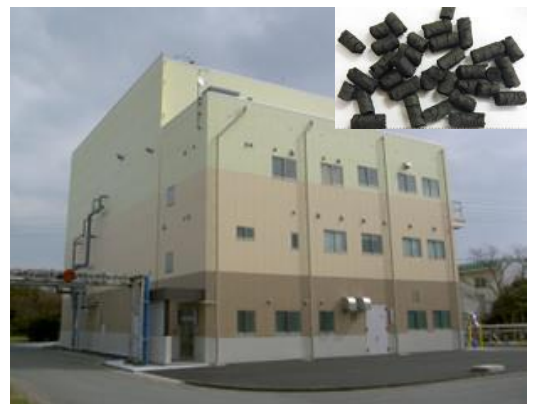
汚泥固形燃料化施設・炭化固形物
