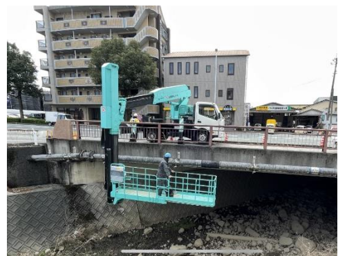
水道橋・橋梁添架管の点検の様子
