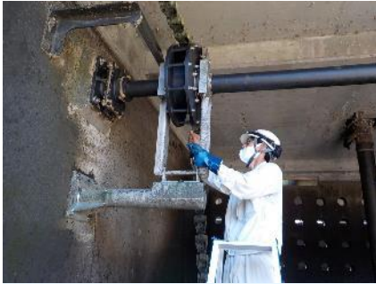
下水道施設の点検調査
