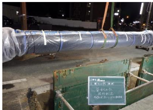
基幹管路配水管更新(水前寺公園付近)
