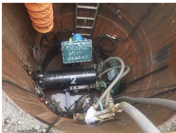
下水道管路の布設(推進工事)
