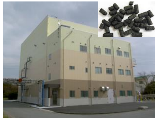
汚泥固形燃料化施設・炭化固形物
