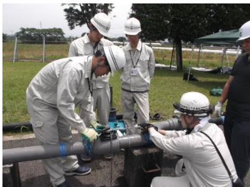
内部講師による配管実技研修
