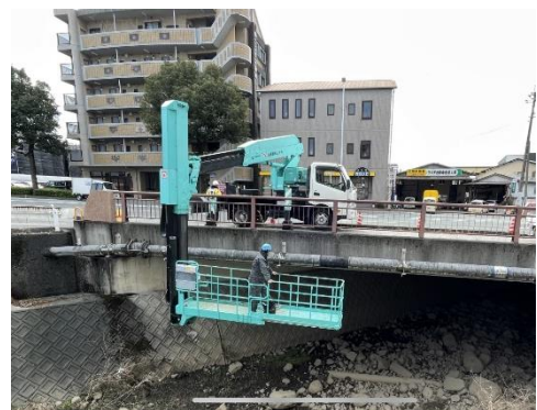
水道橋・橋梁添架管の点検の様子
