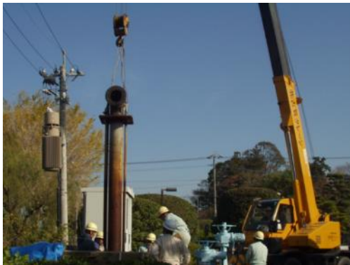
井戸の更生工事
