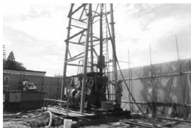
一木取水4号井のさく井工事
