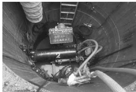
下水道管路の布設工事
