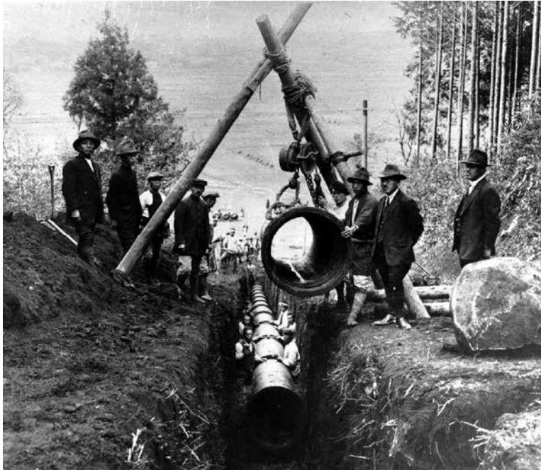
立田山送水管布設工事（大正期）
