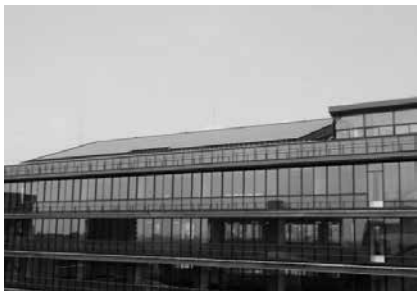
上下水道局本館
