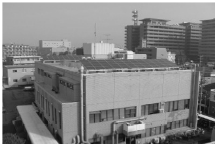
上下水道局別館
