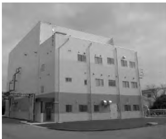
固形燃料化施設
