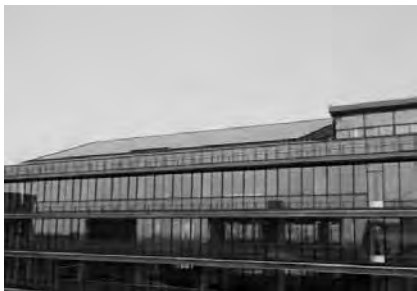
上下水道局本館
