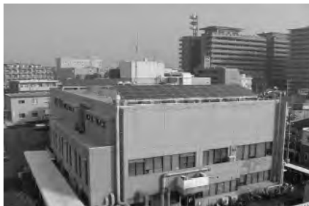
上下水道局別館
