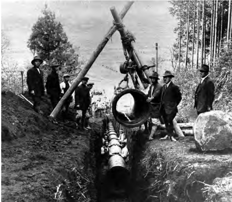
立田山送水管布設工事（大正期）
