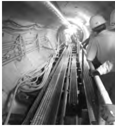
加勢川第6排水区雨水幹線シールド工事
