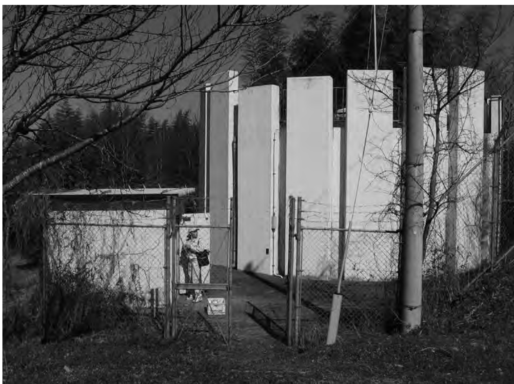
工業用水道配水池
