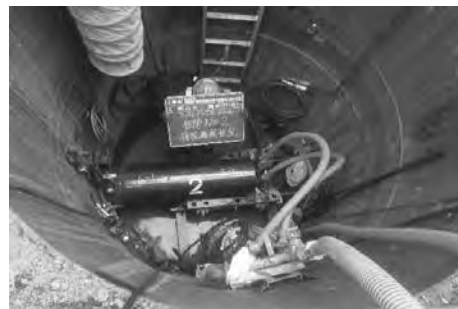
下水道管路の布設工事
