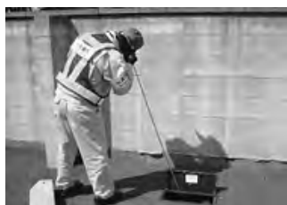
漏水調査の様子
