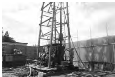
一木取水4号井のさく井工事
