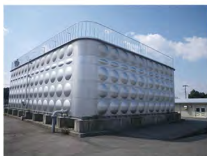
舞原配水場（城南）
