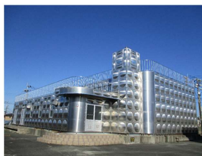
一木配水場（植木）
