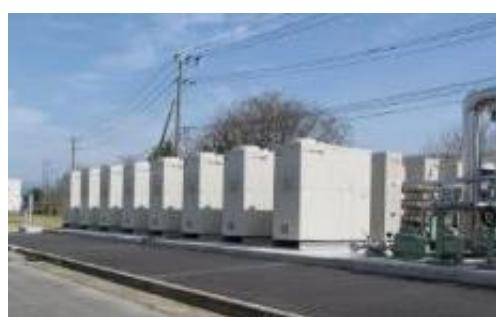
写真 4-3-8 消化ガス発電（東部浄化センター）
