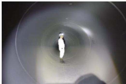
写真 4-3-2 雨水バイパス管
