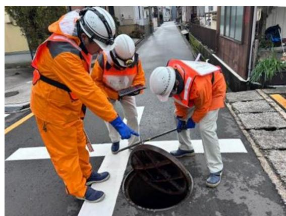
写真 3-4-3-2 下水道施設の被害調査(能登半島地震)
