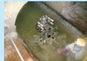
テレビカメラ調査等により、管きよの状態を調べています
