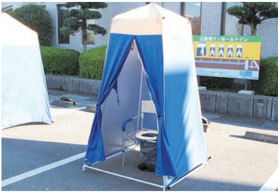
災害用マンホールトイレ
