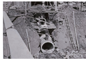
△当時の下水道工事
