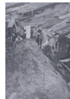
△水害の復旧作業
