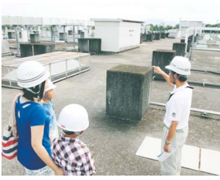
1日に3万トンの下水を処理している南部浄化センターは、24時間稼働。反応タンクの中では、微生物が汚れを食べて沈めてくれます
